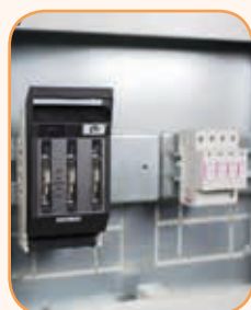
Saugiklių blokai LTL00 ir modulinė įranga
