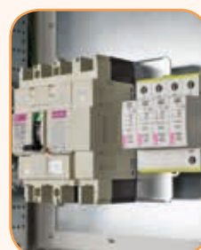
Automatai EB2 160 A ir modulinė įranga
