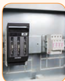
Saugiklių blokai LTL00 ir modulinė įranga
