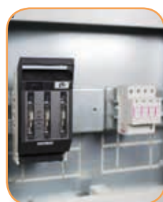
Saugiklių blokai LTL00 ir modulinė įranga
